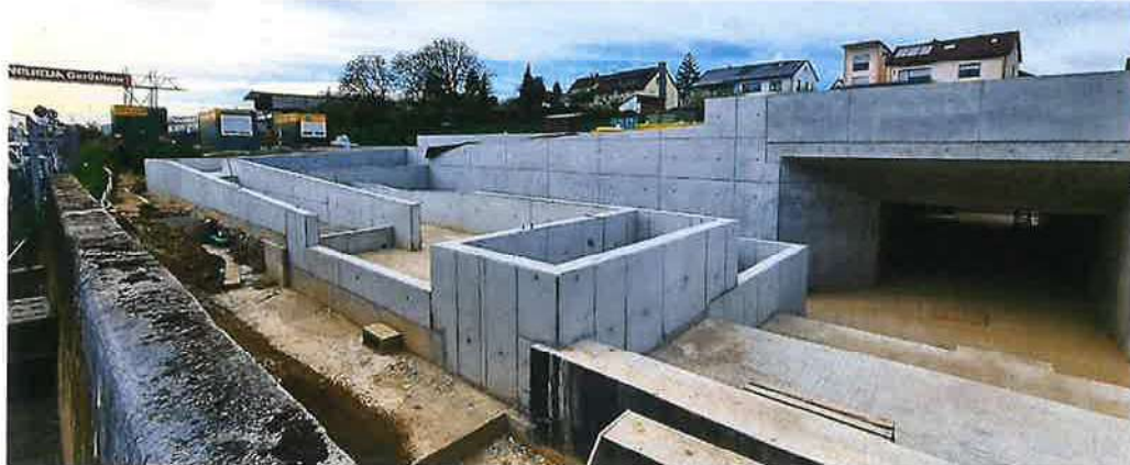
Abbildung 4: Aufnahme des Baus der Unterführung des Bahnhofs als Teil der Gesamtmaßnahme süd-westlich des Plangebietes, Blick von der Robert-Bosch-Straße aus (Aufnahme Büro Baldauf: 11.04.2024)
